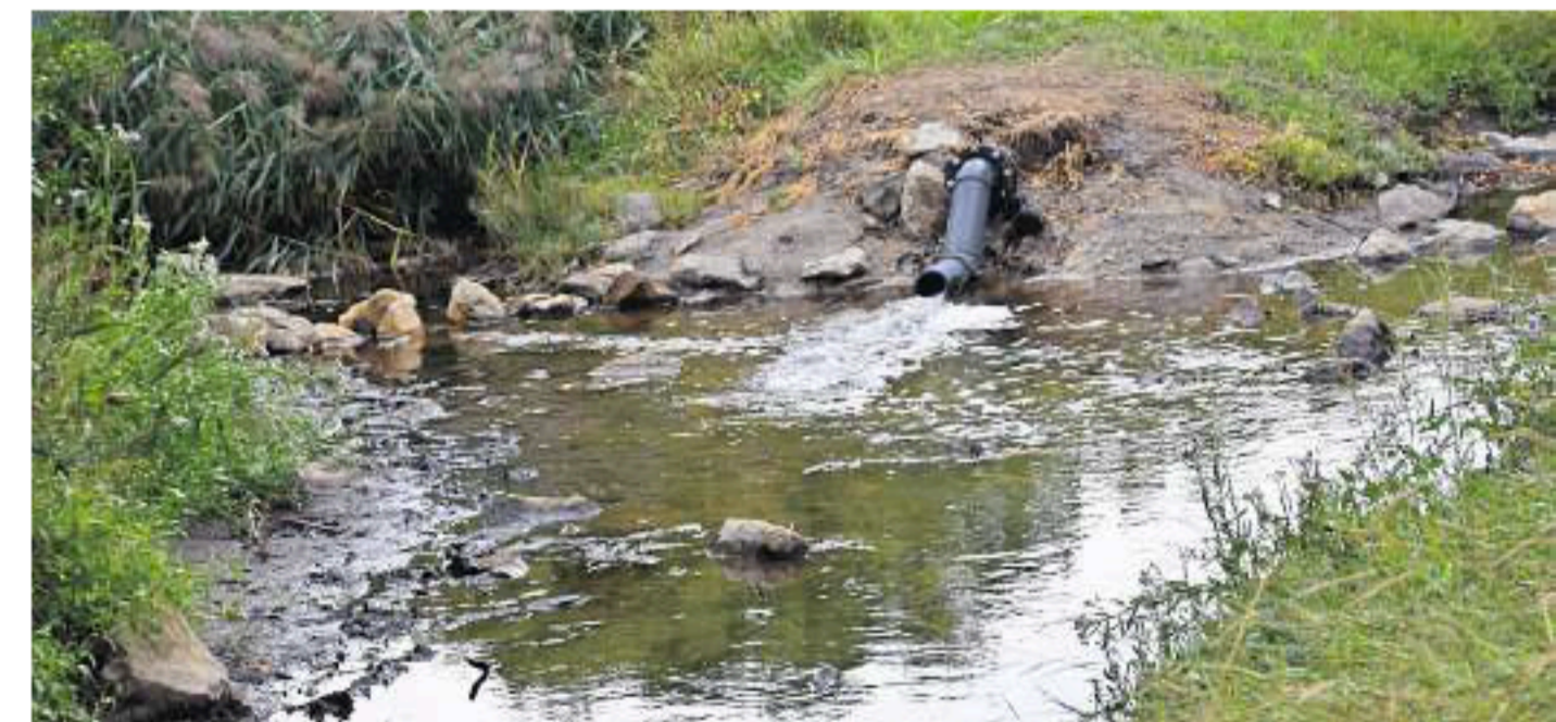
Wenige Meter nachdem das Haldenwasser aus Ronnenberg in die Fösse einleitet wird, ergänzt das Haldenwasser aus Empelde die sogenannte Salzlast des Baches. FOTO: UWE KRANZ
