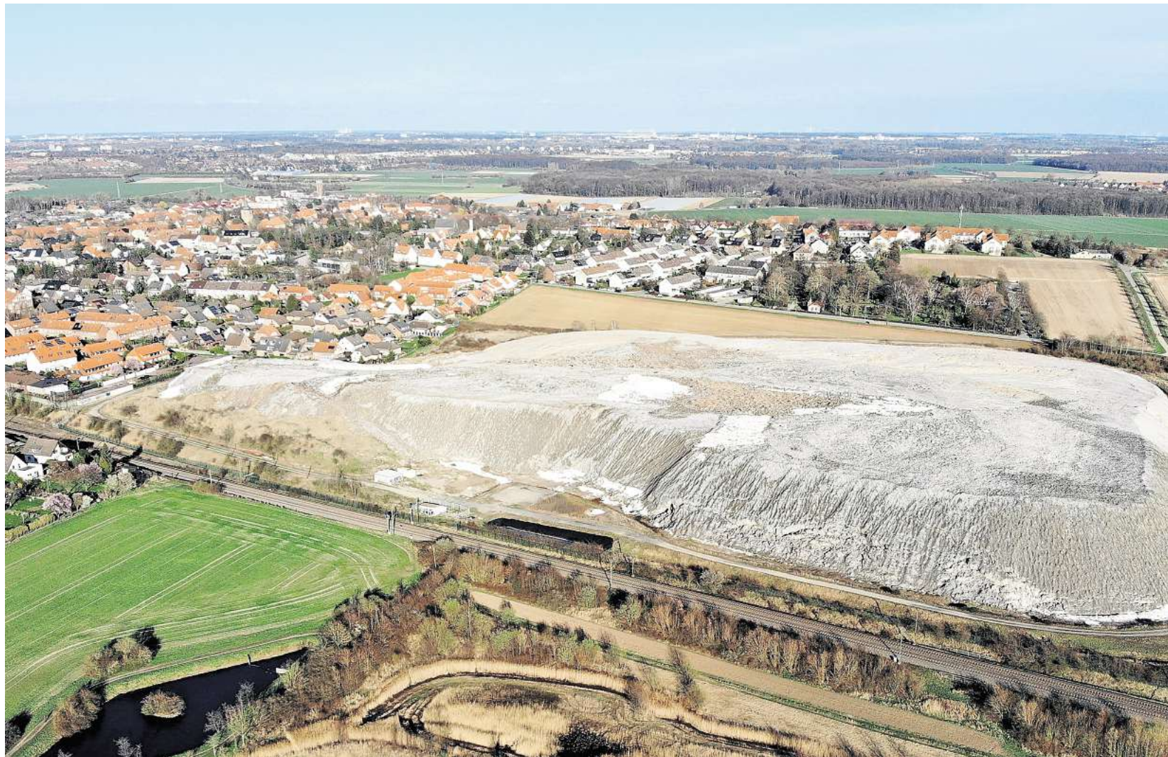
Umstrittene Abdeckung: Aus dem Kaliberg in Ronnenberg wäscht der Regen fortwährend Salze aus – wie kann die Altlast gesichert werden?
